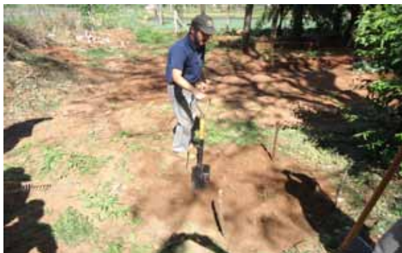
Figura 47 Limpieza del lugar para construir la pila
