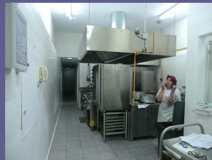
Instalaciones acondicionadas. Cocina Central situada en la residencia municipal. Diciembre 2012
